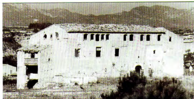
09. Façana est del Mas de la Coixa de Móra la Nova. Estat original.
