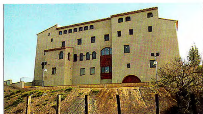
10. Façana oest del Mas de la Coixa de Móra la Nova, un cop rehabilitat.
